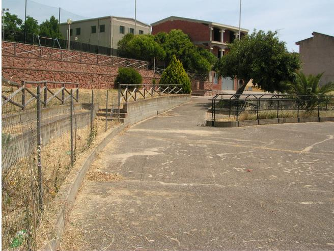
La linea di demarcazione tra la pista di pattinaggio è l'area a verde attrezzato è realizzata appunto mediante un muro in calcestruzzo alto in media 95 cm sormontato da una balaustra in legno; una breve gradinata di tre alzate, anch'essa in calcestruzzo faccia a vista, permette il diretto collegamento delle due zone.
